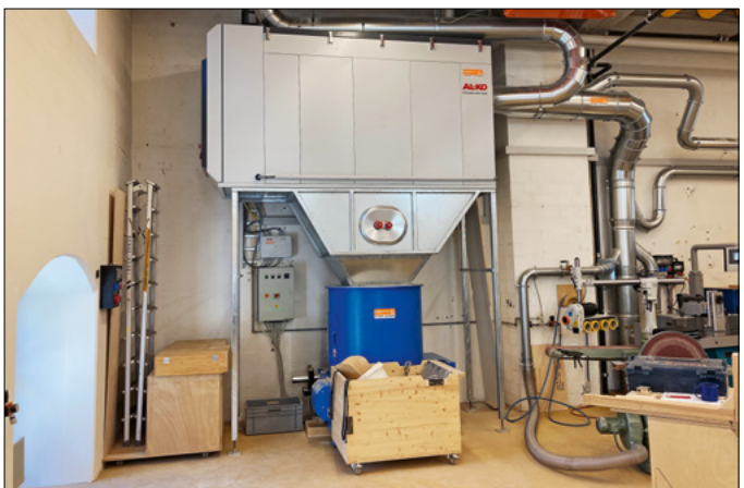
Montage einer Absauganlage mit Brikettierpresse
