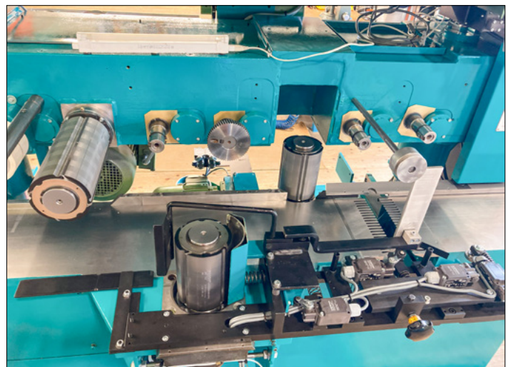
Verkabelung und Endschalter werden neu gemacht
