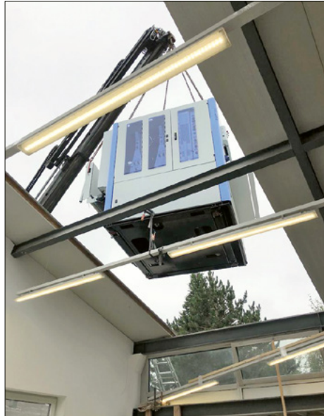
Einbringung einer Breitbandschleifmaschine HOMAG SANDTEQ über ein dafür geöffnetes Werkstattdach. Es wurde ein externer Pneuroman für die Einbringung beim Kunden hinzu gezogen.
