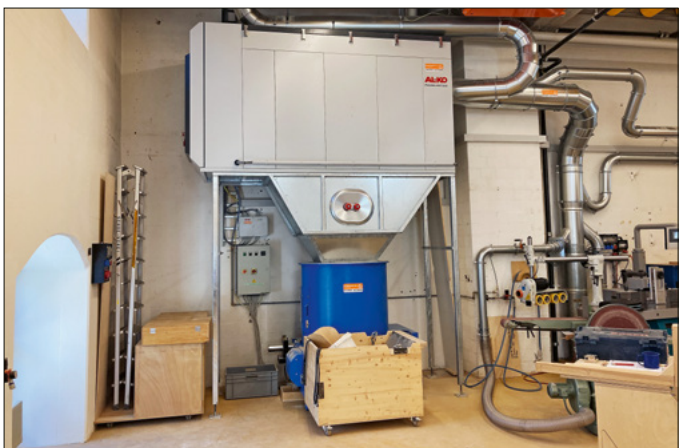
Montage einer Absauganlage mit Brikettierpresse
