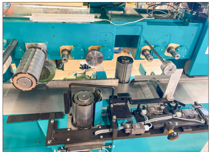
Verkabelung und Endschalter werden neu gemacht
