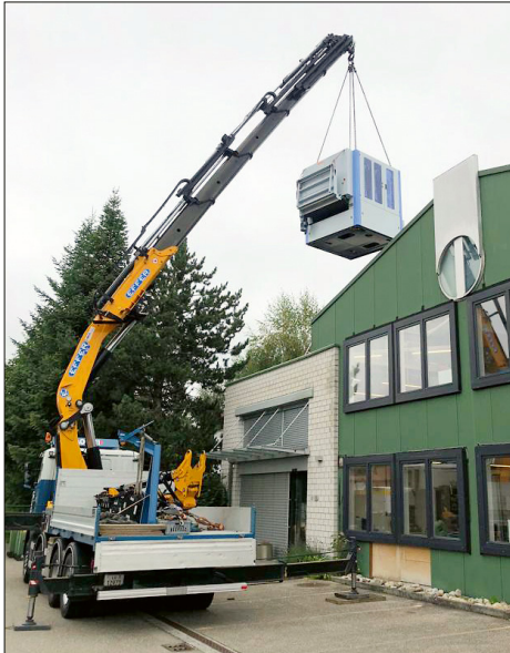
Einbringung einer Breitbandschleifmaschine HOMAG SANDTEQ über ein dafür geöffnetes Werkstattdach. Es wurde ein externer Pneuroman für die Einbringung beim Kunden hinzu gezogen.
