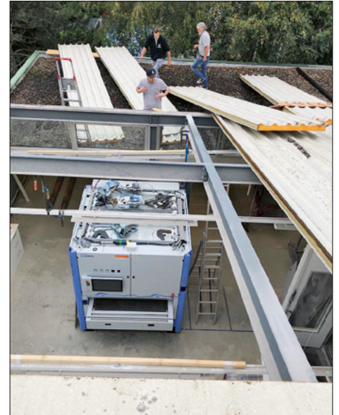
Einbringung einer Breitbandschleifmaschine HOMAG SANDTEQ über ein dafür geöffnetes Werkstattdach. Es wurde ein externer Pneuroman für die Einbringung beim Kunden hinzu gezogen.
