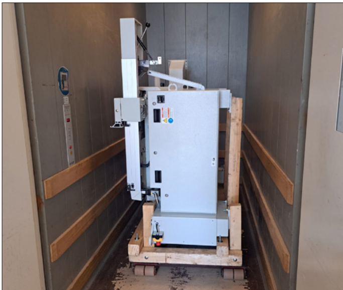
Befördern mit dem Lift ins Obergeschoss
