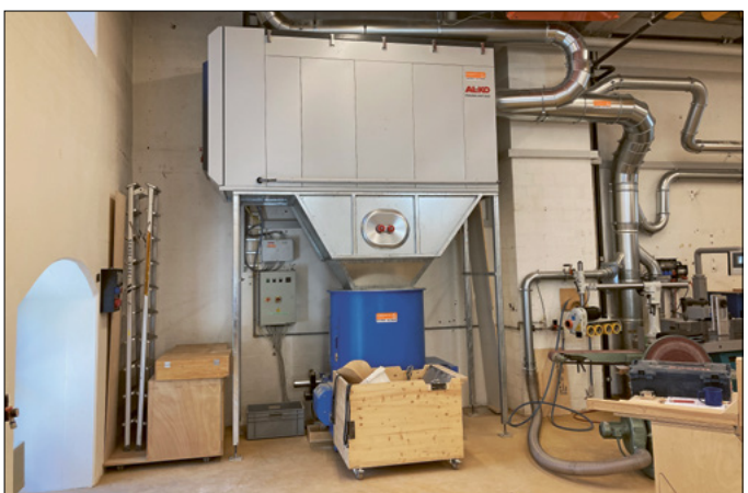
Montage einer Absauganlage mit Brikettierpresse
