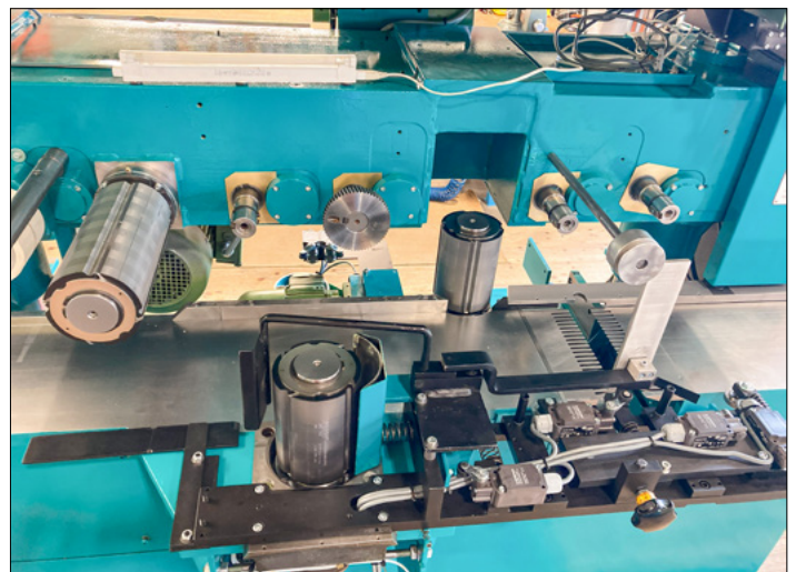
Verkabelung und Endschalter werden neu gemacht
