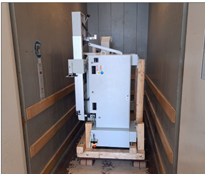
Befördern mit dem Lift ins Obergeschoss
