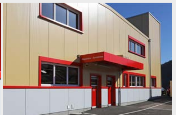
Aussenansicht des neuen Werkstatt-Anbaus
