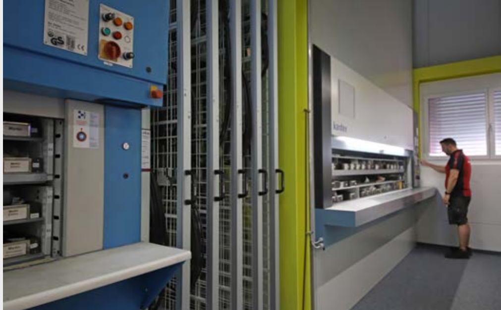
Die Anzahl Warenlifte wurde von 2 auf 4 Stück erweitert
