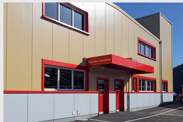
Aussenansicht des neuen Werkstatt-Anbaus
