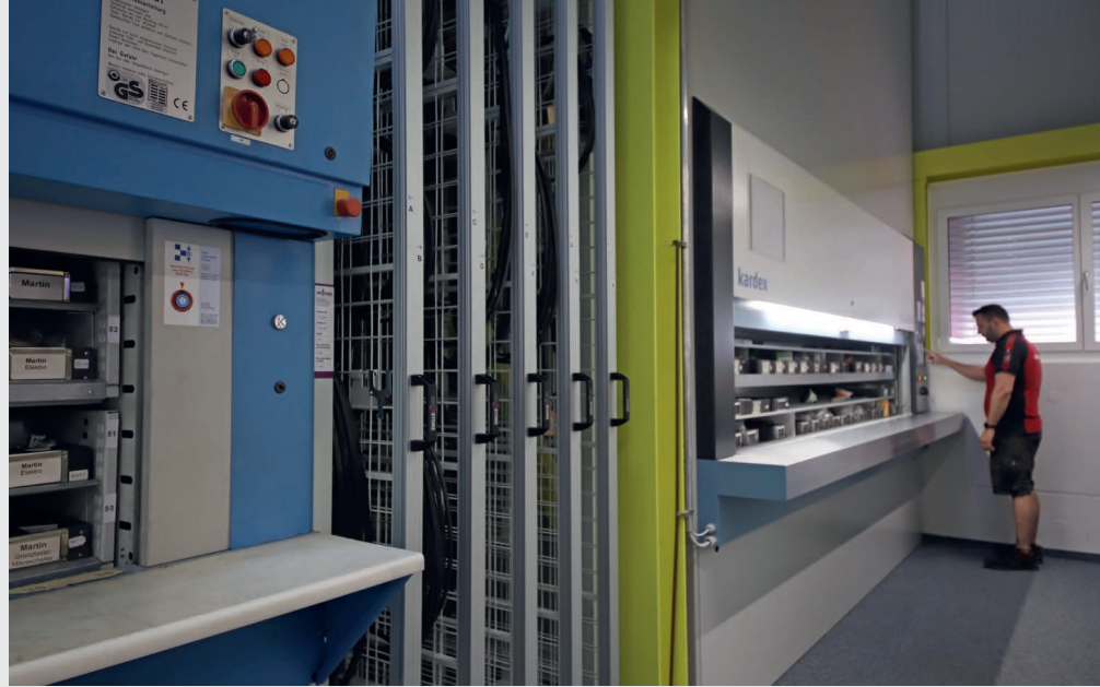
Die Anzahl Warenlifte wurde von 2 auf 4 Stück erweitert
