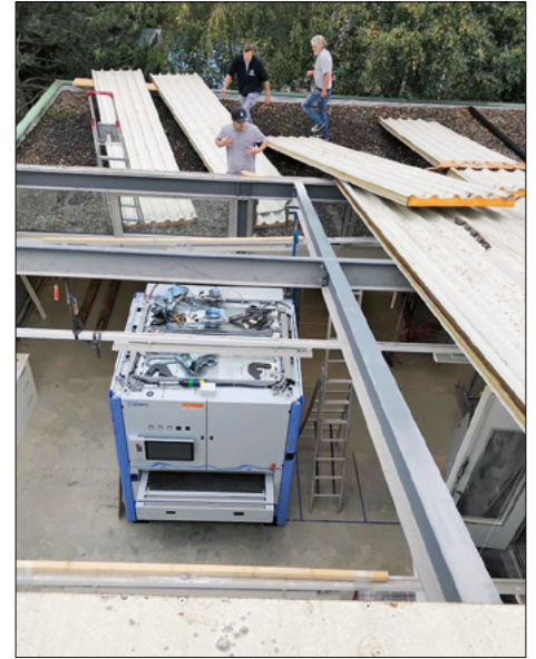
Einbringung einer Breitbandschleifmaschine HOMAG SANDTEQ über ein dafür geöffnetes Werkstattdach. Es wurde ein externer Pneukran für die Einbringung beim Kunden hinzu gezogen.
