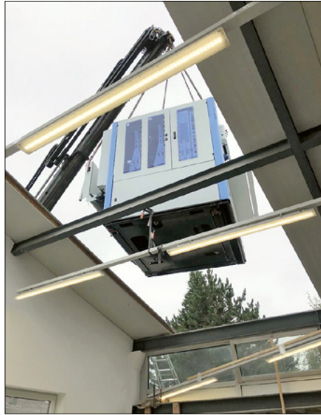
Einbringung einer Breitbandschleifmaschine HOMAG SANDTEQ über ein dafür geöffnetes Werkstattdach. Es wurde ein externer Pneukran für die Einbringung beim Kunden hinzu gezogen.
