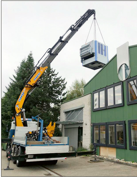
Einbringung einer Breitbandschleifmaschine HOMAG SANDTEQ über ein dafür geöffnetes Werkstattdach. Es wurde ein externer Pneukran für die Einbringung beim Kunden hinzu gezogen.
