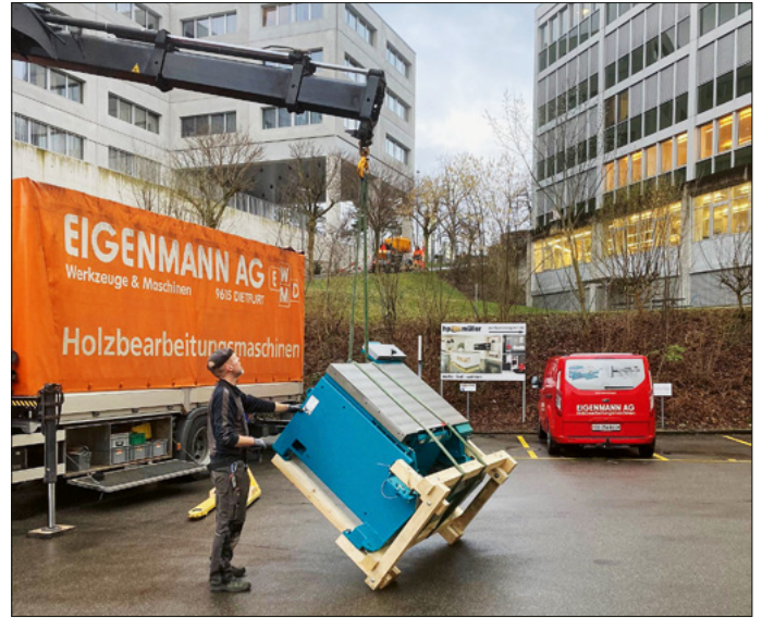
Mit dem Kran wird die Maschine entladen und für die Einbringung aufgestellt
