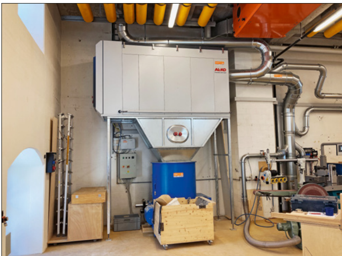
Montage einer Absauganlage mit Brikettierpresse
