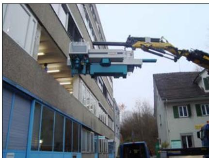
Einbringung im zweiten Obergeschoss mit Spezialvorrichtung
